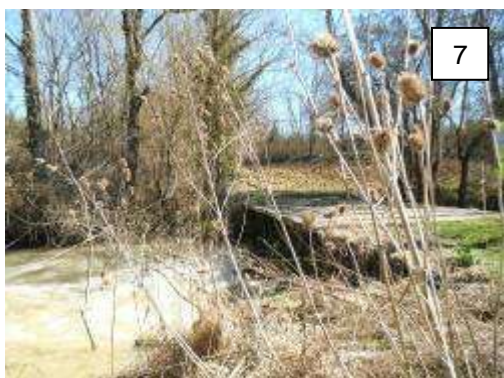
Figure 95 : Photos des ponts de la zone d'étude (6 et 9 mars 2015)
